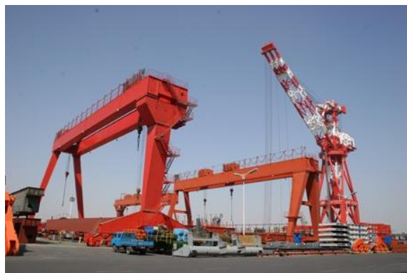
图 1 泉水厂区临海总装码头上的大型起重设备
